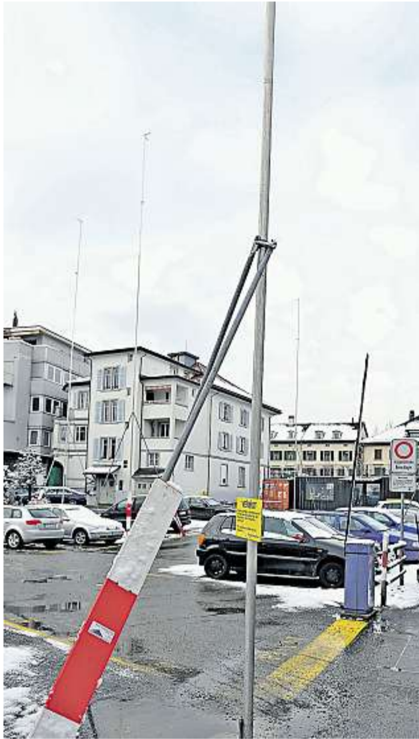
Bereits stehen die Profile für den Stadthof Süd. Bild: Manuela Matt
